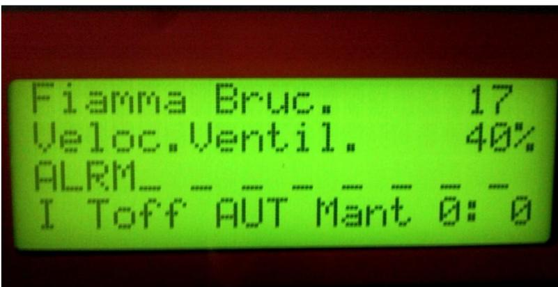
La terza pagina visualizza l'intensità della fiamma del bruciatore, la velocità del ventilatore e lo stato degli allarmi.
