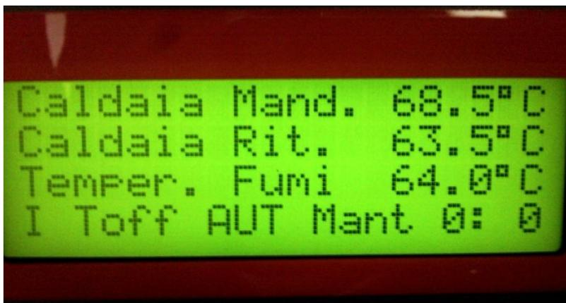
La prima pagina fornisce la lettura delle tre sonde di mandata e ritorno caldaia e la temperatura dei fumi .
