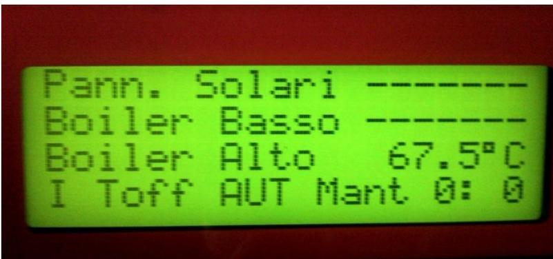
La seconda pagina fornisce la lettura della sonde dei pannelli solari del boiler o accumulo punto basso e punto alto.
